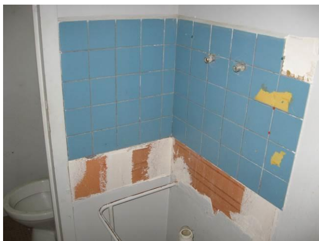
P 29: bâtiment Ancien Hôtel - niveau RDC - Local ménage - Colle de faïence - Photo n° 29
