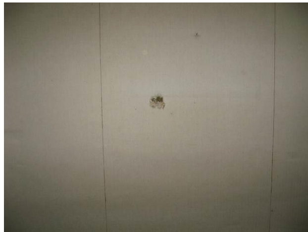
P 20: bâtiment Ancien Hôtel - niveau RDC - Salle arrière - Enduit mural+feuille alu+moquette murale - Photo n° 20
