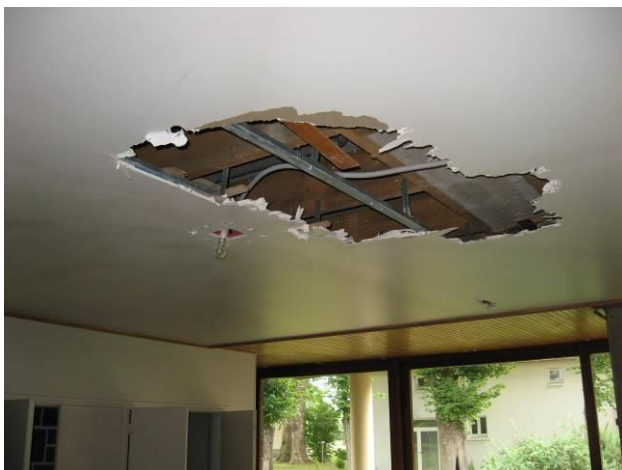
P 9: bâtiment Ancien Hôtel - niveau RDC - Salle de réception - Enduit bande à Placo au plafond - Photo n° 9
