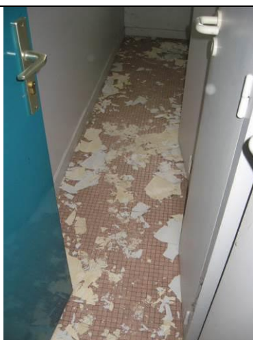
P 65: bâtiment Ancien Hôtel - niveau R+2 - Local ménage - Colle de carrelage - Photo n° 65
