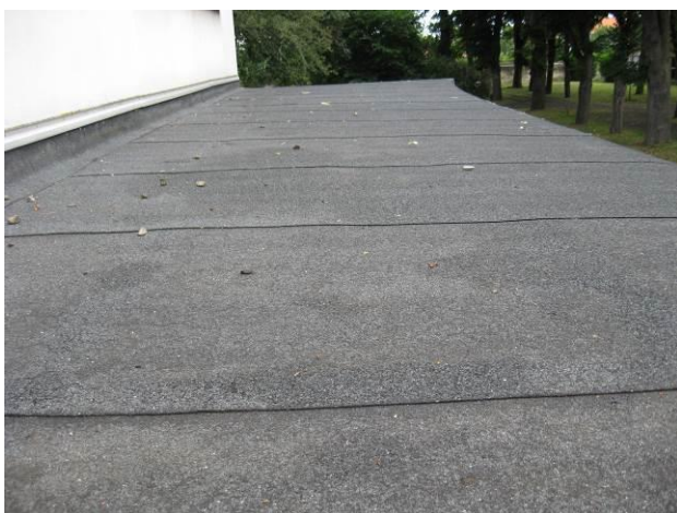
P 17: bâtiment Ancien Hôtel - niveau Toiture - Casquette côté salle de réception - Complexe d'étanchéité Shingle - Photo n° 17
