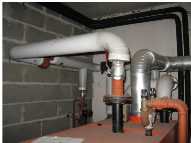
P 2: bâtiment Ancien Hôtel - niveau RDC - Chaufferie - Calorifugeage - Photo n° 2
