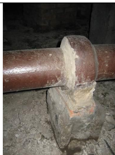
P 12: bâtiment Ancien Hôtel - niveau R-1 - Vide sanitaire - Enduit de rebouchage tuyauterie - Photo n° 12
