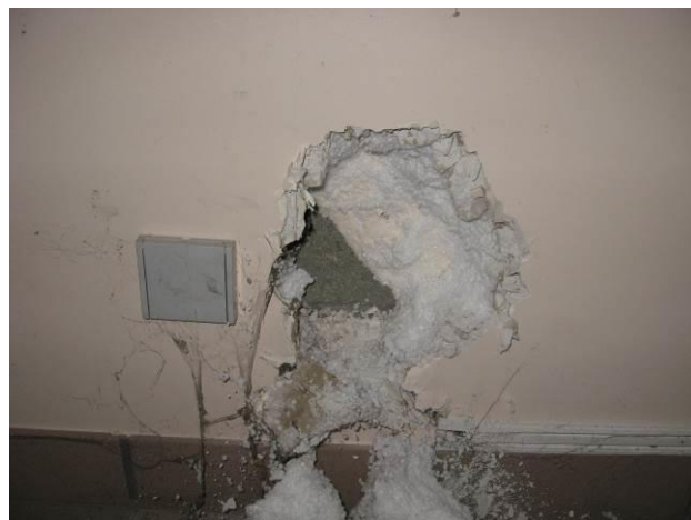
P 38: bâtiment Ancien Hôtel - niveau RDC - Grande salle extension - Colle type MAP au mur - Photo n° 38
