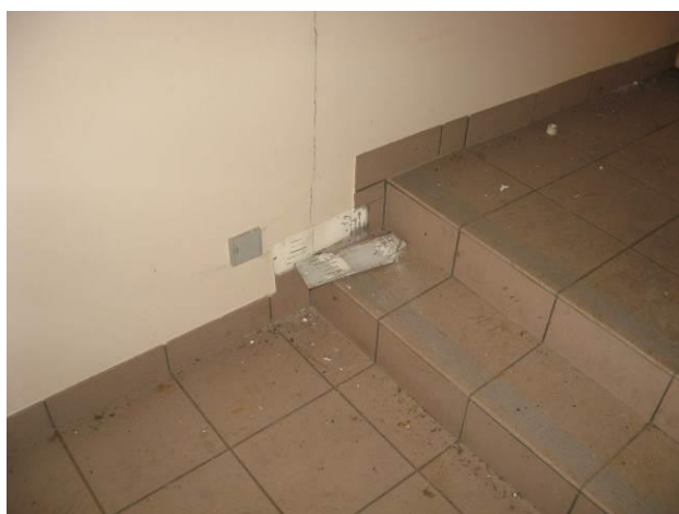
P 33: bâtiment Ancien Hôtel - niveau RDC - SAS accès extension - Colle de plinthe - Photo n° 33
