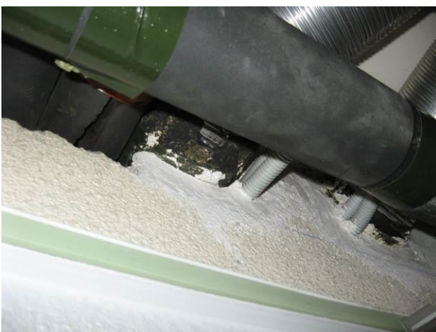
P 71: bâtiment Ancien Hôtel - niveau R+1 - Circulation - Feutre bitume passage cloison - Photo n° 71
