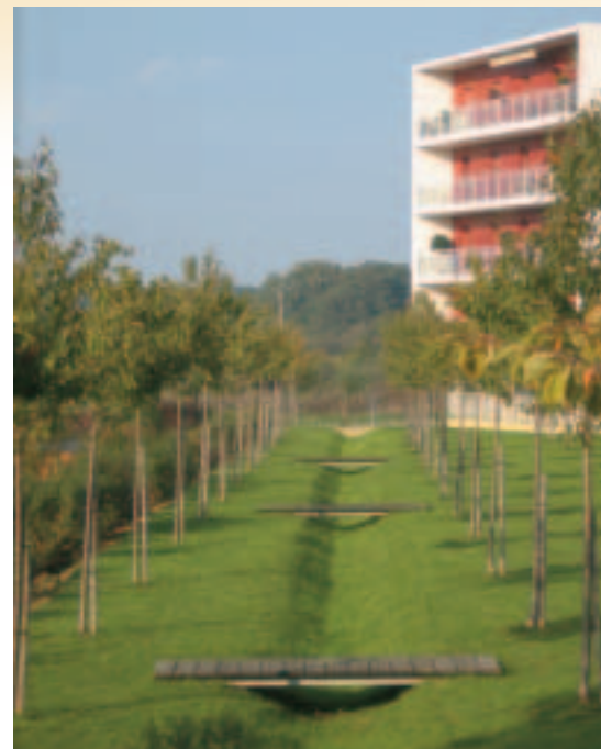
Exemples de noues et espaces verts.
