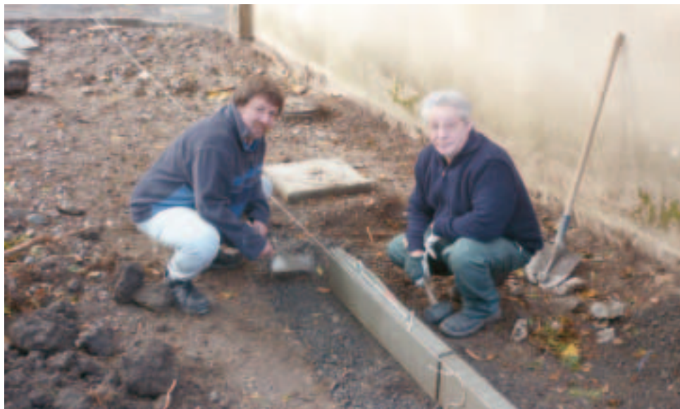
Petits travaux de maçonnerie au domaine de La Prade.
